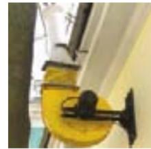
Вентиляторы FUK оснащены монтажными кронштейнами, позволяющими крепить вентилятор в любой пространственной ориентации.
